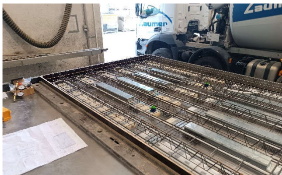
Abbildung 1: Deckenplatte mit Bauteilaktivierung und Schallkörper für die Aussparungen der Absorber
